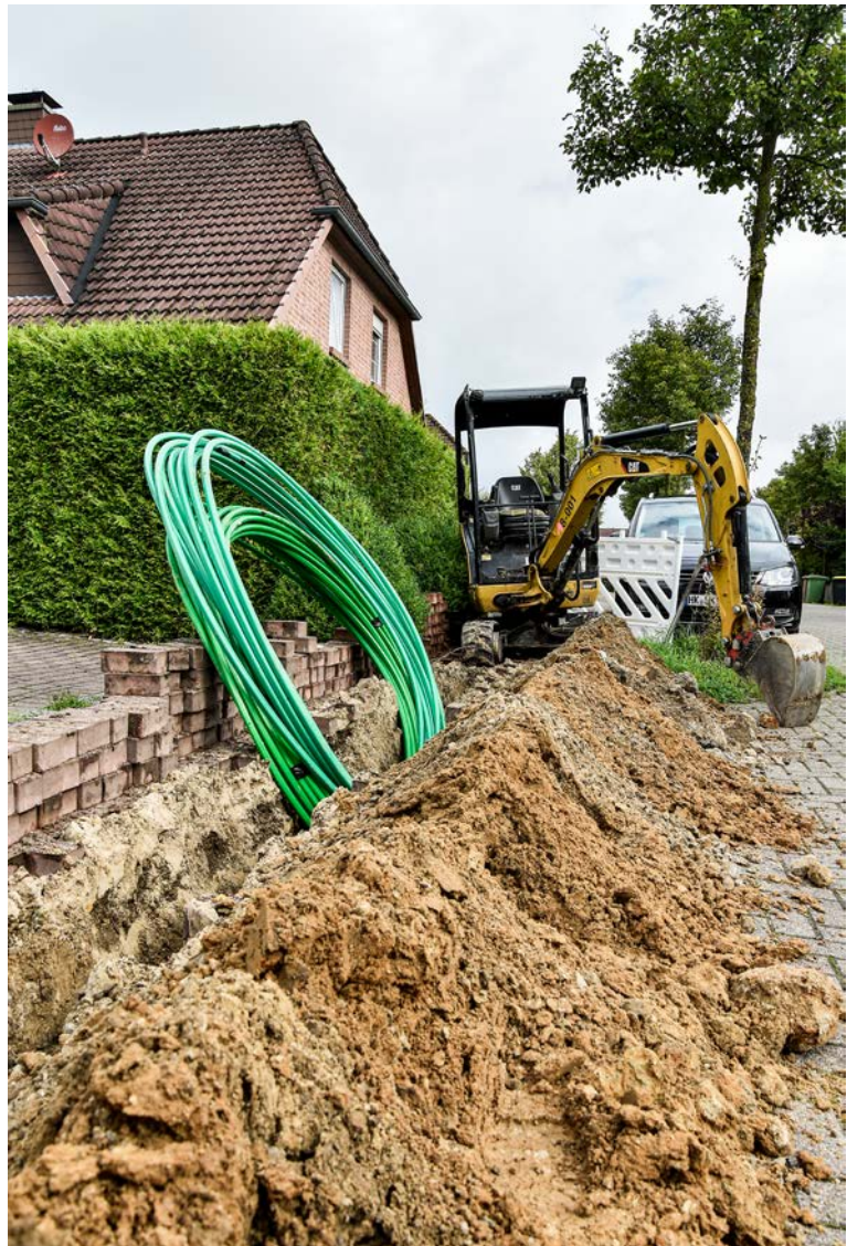
Glasfaser unter dem Gehweg Im Sommer 2023 starteten die Bauarbeiten am Meirehmer Berg.
