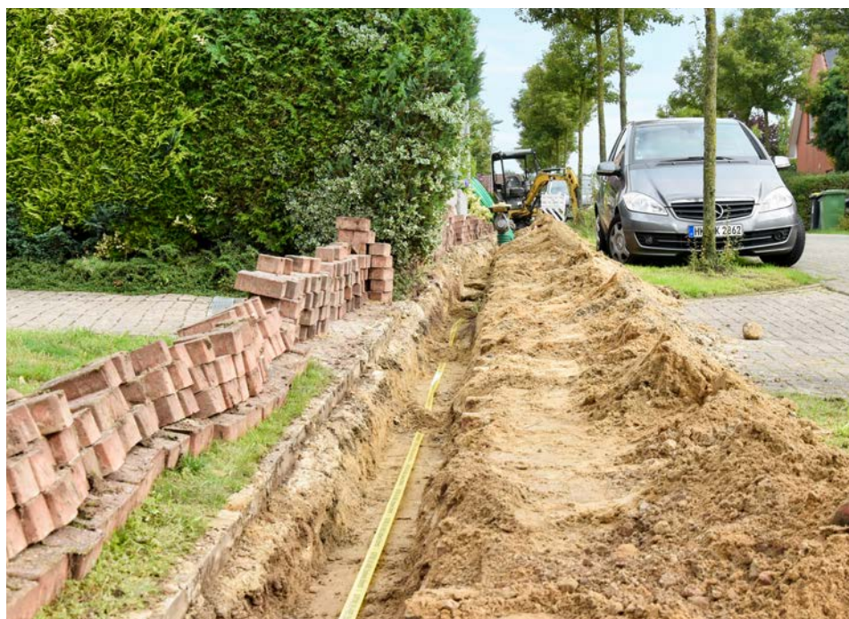
Der Anfang ist gemacht Der Schacht für die Leer- rohre ist gegraben.
