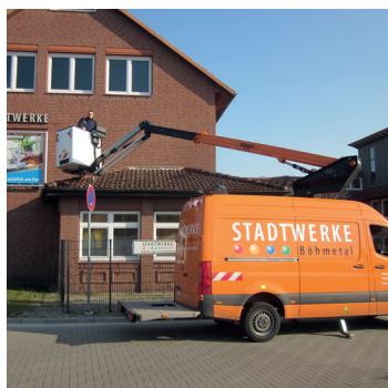
Hubsteiger im Einsatz
