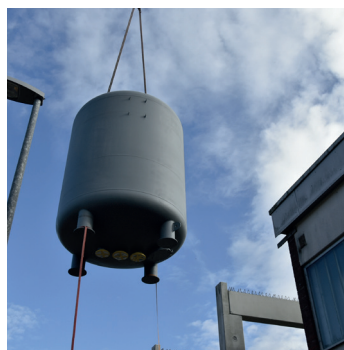
Montage Filterkessel im WW Düşhorn
