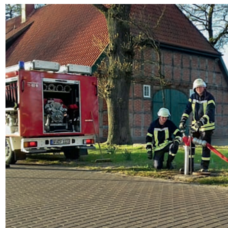
Bereit für den Löscheinsatz? Feuerwehrleute in Eilte beim Überprüfen eines Unterflurhydranten
