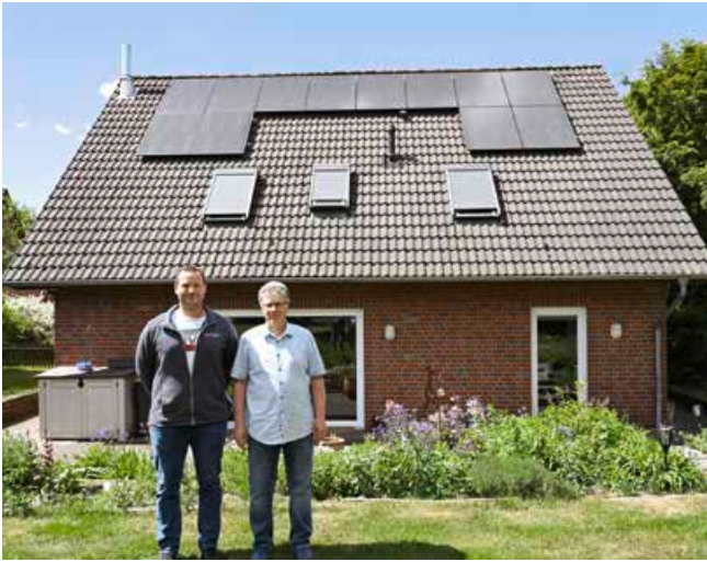
Die erste PV-Anlage ist installiert:
