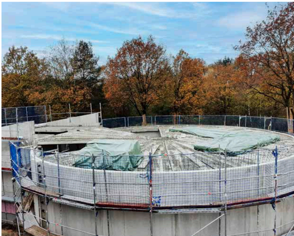
Eingerüstet Eine Spezialfirma aus Süddeutschland errichtet die neuen Speicher, die aus runden Fertigbauteilen bestehen. Der Behälter auf dem Foto ist inzwischen erdbedeckt.
