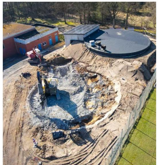
**Baufortschritt** Ein neuer Reinwasserbehälter ist in Betrieb. Am zweiten wird derzeit gebaut.
