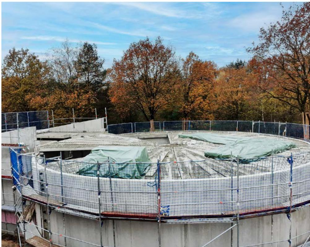
**Eingerüstet** Eine Spezialfirma aus Süddeutschland errichtet die neuen Speicher, die aus runden Fertigbauteilen bestehen. Der Behälter auf dem Foto ist inzwischen erdbedeckt.
